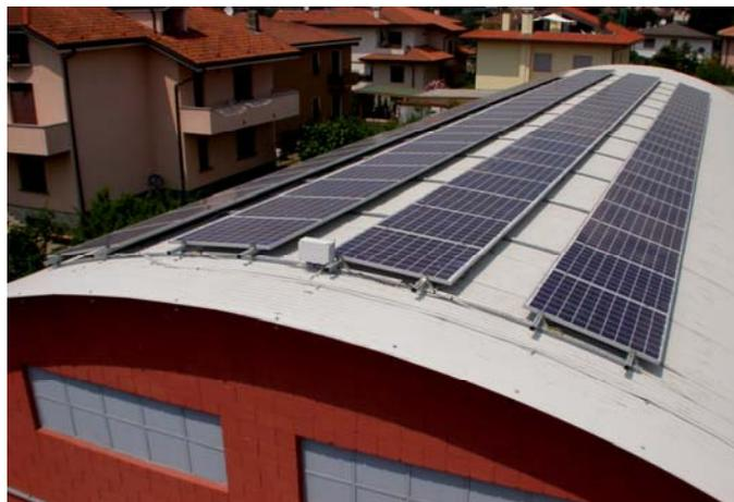
Le strutture di sostegno, aventi uno sviluppo lineare di quasi 270 metri lineari, sono realizzate con componentistica che abbiamo sviluppato specificatamente per il settore.
