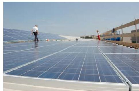
Il numero totale di moduli è 630 di marca Aleo-solar GmbH, mod. S18-220W, per una potenza complessiva di 138,60 kWp.
