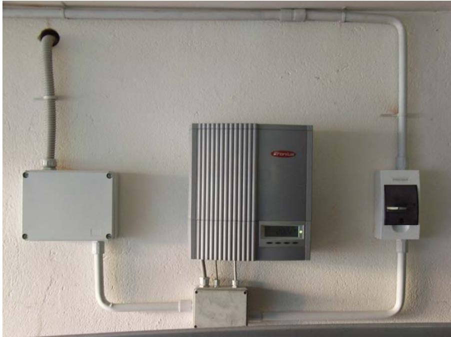
Le 2 stringhe elettriche di corrente continua fotovoltaica convergono su **1** inverter **Fronius IG 30**, che trasformano la corrente in alternata, la quale viene quindi immessa nella rete elettrica
