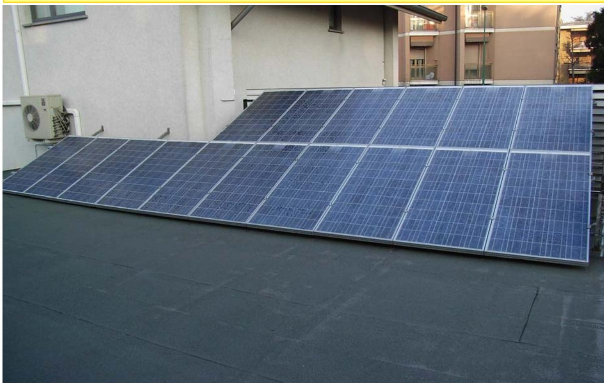
Le strutture di sostegno sono interamente realizzate in acciaio inox Aisi 304 o alluminio, prodotte internamente alla **Tecno-Proget**: ciò al fine di assicurare la massima durata e resistenza negli anni.
