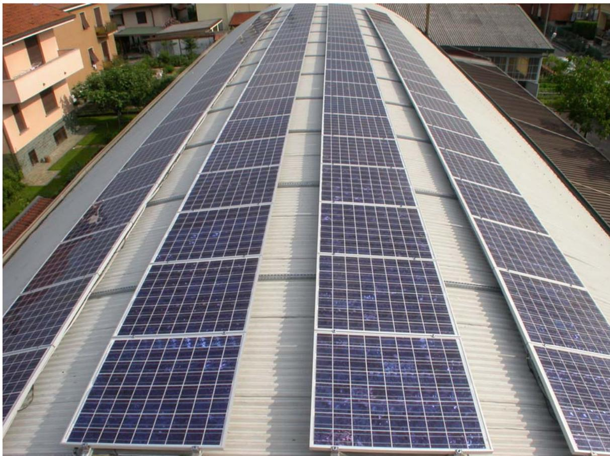
Le strutture di sostegno, aventi uno sviluppo lineare di quasi 270 metri lineari, sono realizzate con componentistica che abbiamo sviluppato specificatamente per il settore.
