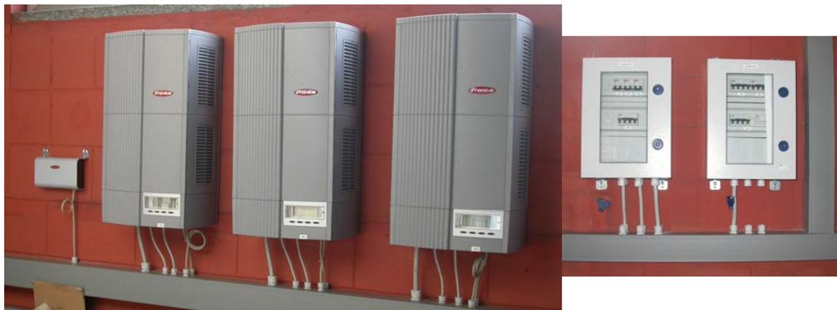
Le 9 stringhe elettriche di corrente continua fotovoltaica convergono su **3 inverter Fronius IG 40**, che trasformano la corrente in alternata, la quale viene quindi immessa nella rete elettrica Nazionale o direttamente consumata.
